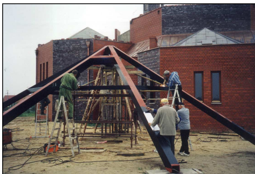
Konstrukcja dachowa na prezbiterium - maj 2002 r.
