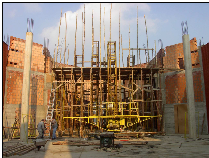
Trwają prace przy budowie kościoła. W tym roku, w piątą rocznicę powstania parafii, kościół ma być przykryty i zamknięty.
