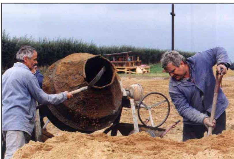
Zalowanie fundamentów kaplicy
